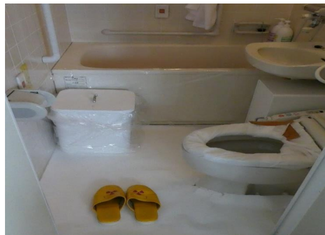
養生したトイレ周囲
